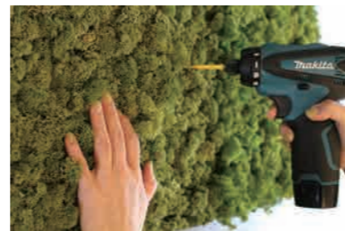
step3 パネルをビスで固定する ※ビスでモスを巻き込まないように注意
